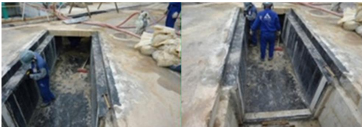
Figura 14 - Reforma das canaletas
