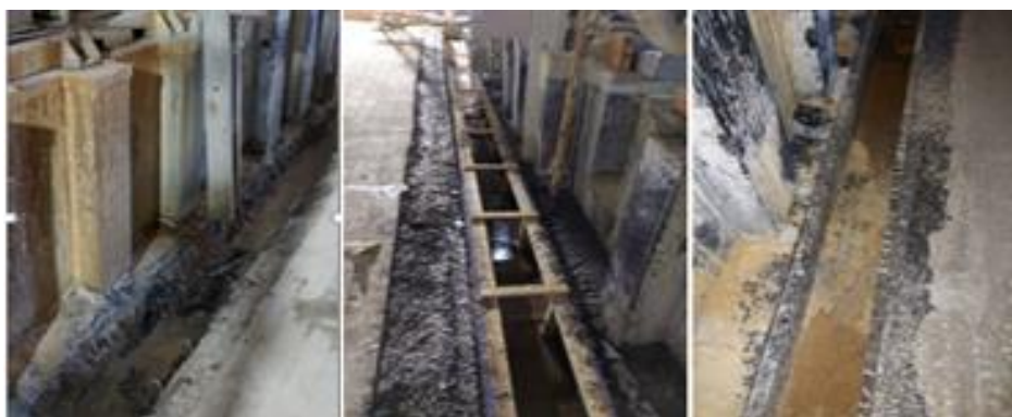
Figura 6 - Etapas de demolição, recuperação e revestimento de canaletas
