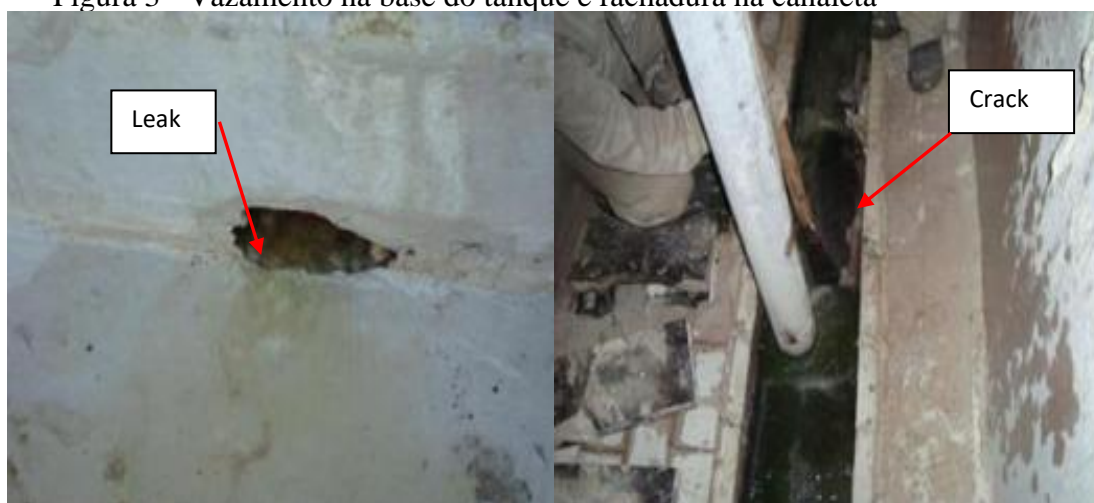
Figura 3 - Vazamento na base do tanque e rachadura na canaleta
